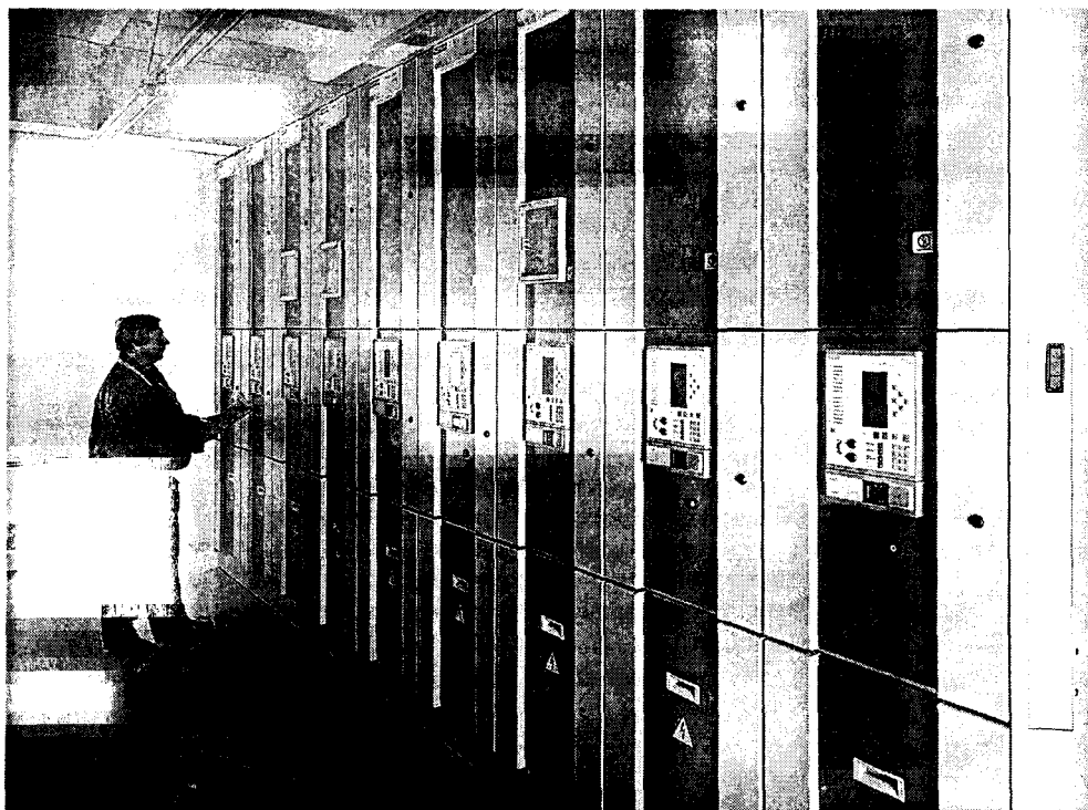
Рис. 4.8. Общий вид панелей с установкой цифровых защит
